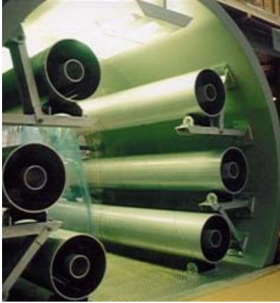
Abb. 31: Beispiel einer Verkabelung bei einem bergmännisch erstellten Stollen (begeh-, teilweise befahrbar)
