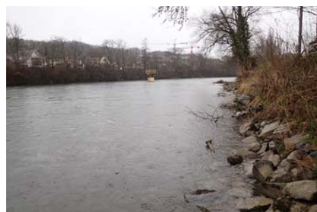
Ufer rechts (Blick abwärts)
