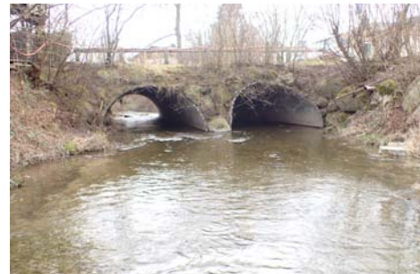
Ufer rechts (Blick abwärts)
