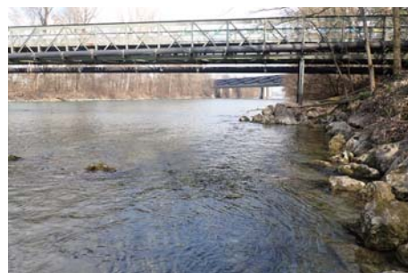
Ufer rechts (Blick abwärts)
