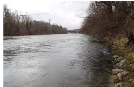
Ufer rechts (Blick abwärts)
