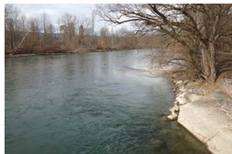
Ufer rechts (Blick abwärts)
