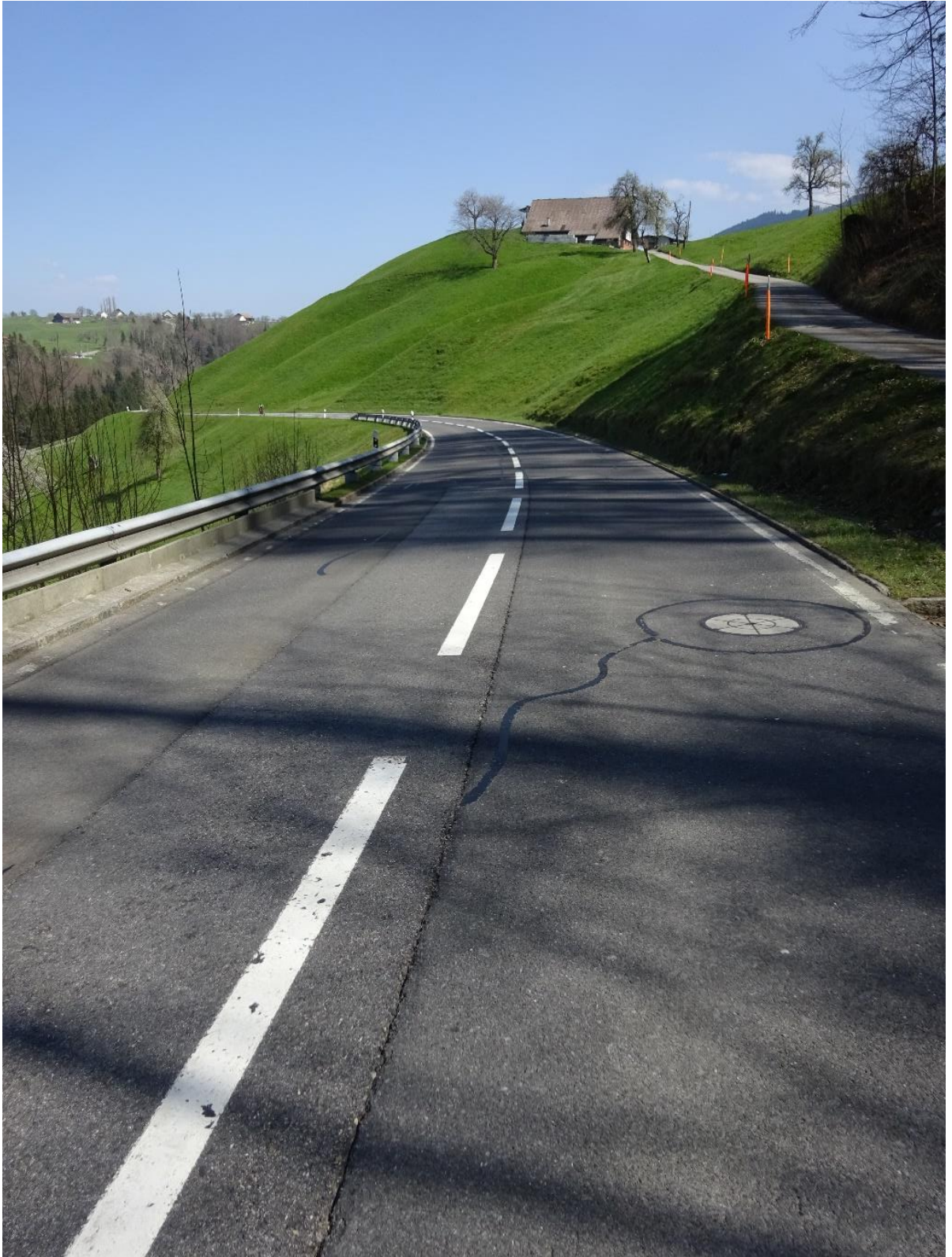
Die Neudorfstrasse in Menzingen wird auf dem Abschnitt von Finstersee bis zur Kantonsgrenze Zug/Zürich saniert.
