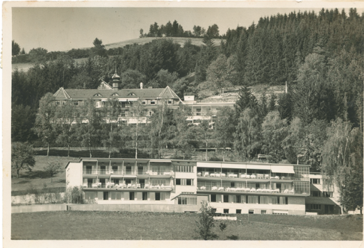
Die beiden von Adelheid Page gestifteten Heime «Heimeli» und «Adelheid» in Unterägeri, um 1940, Privatsammlung.
