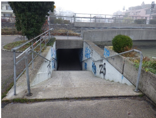
Abbildung 3 bestehender Zugang zur Unterführung
