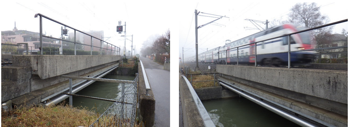
Abbildung 5 bestehende Brücke SBB
