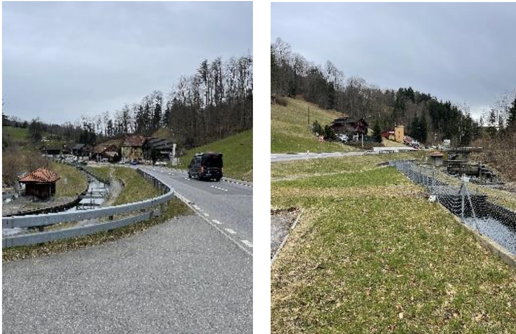
Abb. 22 und 23: Kanalanlage im Bereich Rössli
