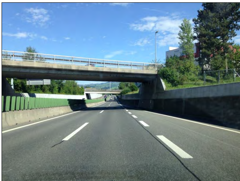
Abbildung 49 Autobahn in Wannenlage (Richtung Osten)
