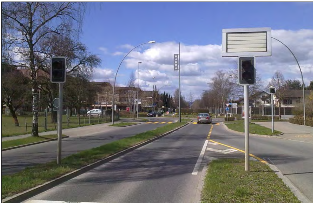
Abbildung 39 Beispiel einer Dosierungsanlage in Kleinwabern/BE (Foto: Gruner)
