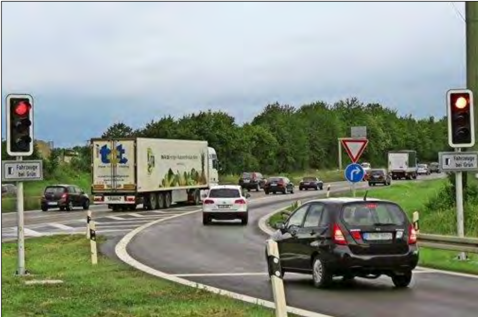
Abbildung 47 Beispiel einer Dosieranlage (B 27, Stuttgart Deutschland)
