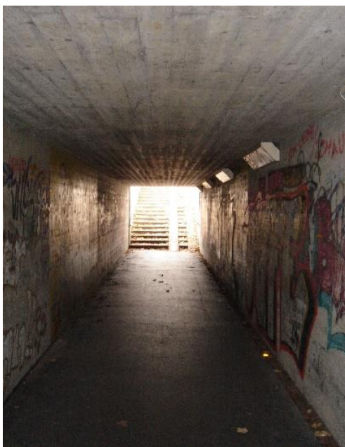
Unterführung Blickrichtung Süd
