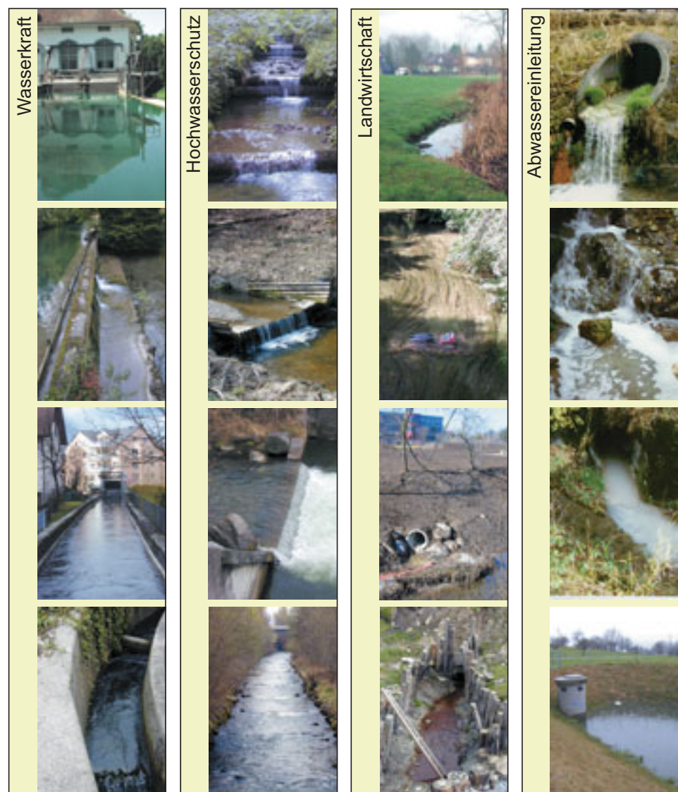
Abbildung 24: Beeinträchtigungen in Zuger Fließgewässern, Aufnahmen aus dem Kanton Zug
