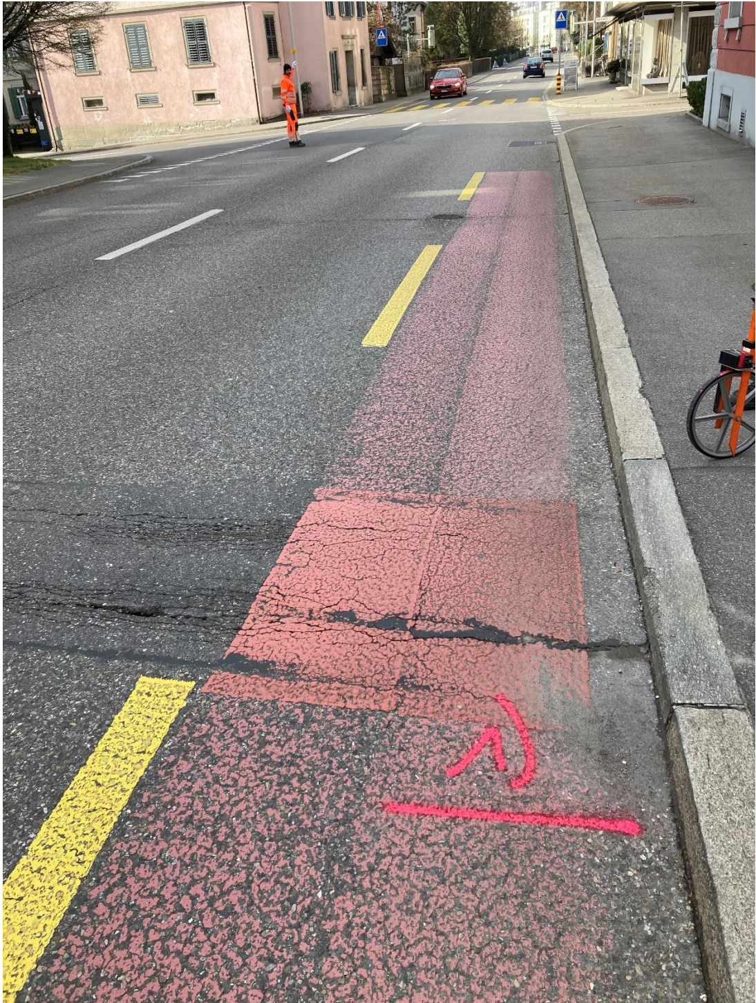
Der Belag der Luzernerstrasse in Cham wird während zweier Nächte repariert.
