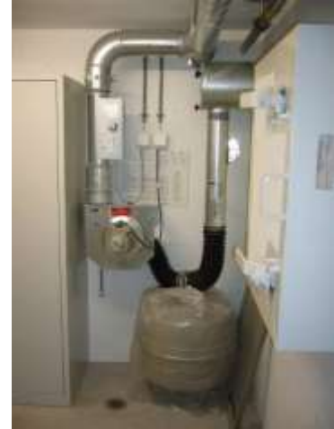
Ventilationsaggregat mit Direktverteilung
