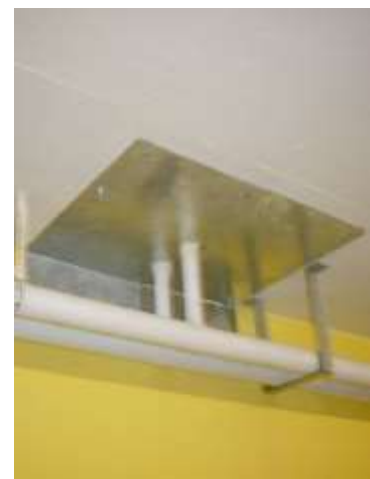
Heizleitung (Deckendurchführung)
