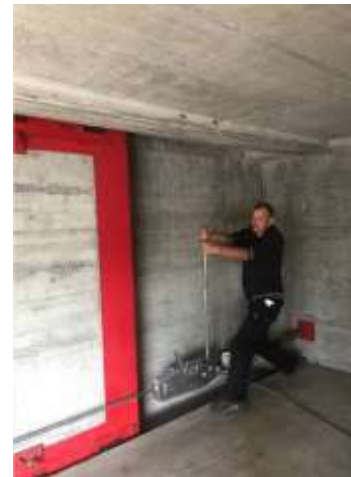
Panzerschiebewand (PSW) mit Seilzugapparat
