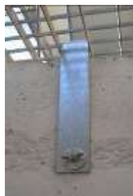
Notausstieg NA mit Gitter und Winkeleisen
