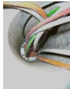
Wanddurchführung mit ein und mehreren Kabeln. Gas- und druckfesten Einlage (ab zwei Kabel zwingend)
