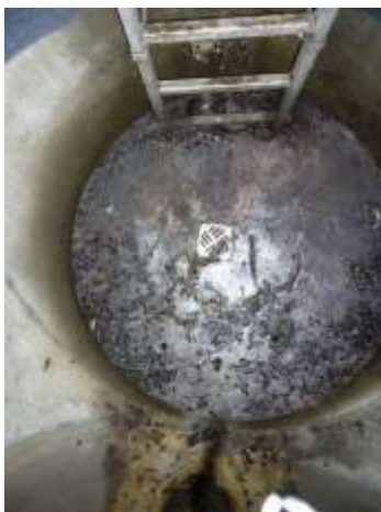
Sickerung mit Bodenablauf
