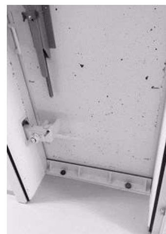
Panzertüre (PT1) mit demontierbarer Schwelle
