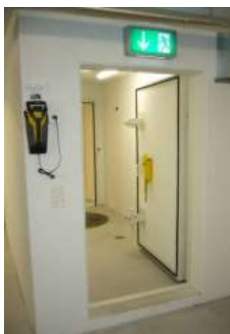
Panzertüre (PT1) mit betonierter Schwelle
