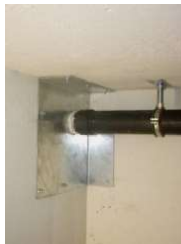
Dachwasserleitung (Wanddurchführung)
