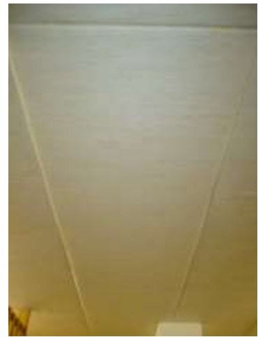
Deckendämmung mit Schienensystem
