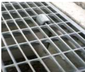
Notausstieg NA mit Gitter und Winkeleisen
