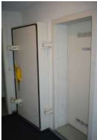
Panzertüre (PT1) mit betonierter Schwelle
