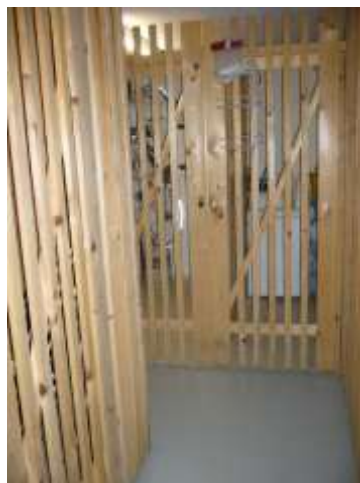
Trennwände aus Holz
