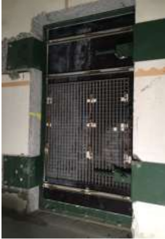
Nachträgliche Panzertüre (PT) mit demontierbare Schwelle
