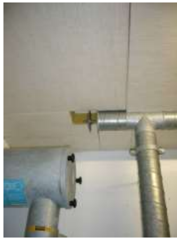
Deckendämmung punktgeklebt
