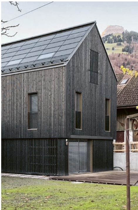
3 Ganzflächige «Indach»-Solaranlage.
