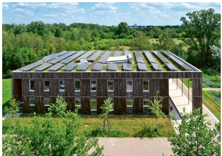
4 Solaranlage auf extensiv begrüntem Flachdach.
